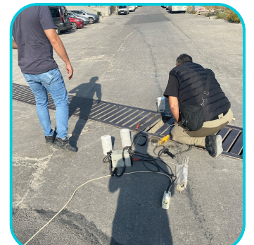
Yağmur Mazgalları Tamirat ve Temizliği
